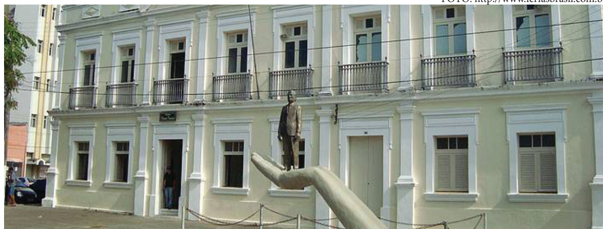
Obra está orçada no valor de R$ 211.602,58: estão previstos serviços de manutenção, acessibilidade e climatização do Memorial
